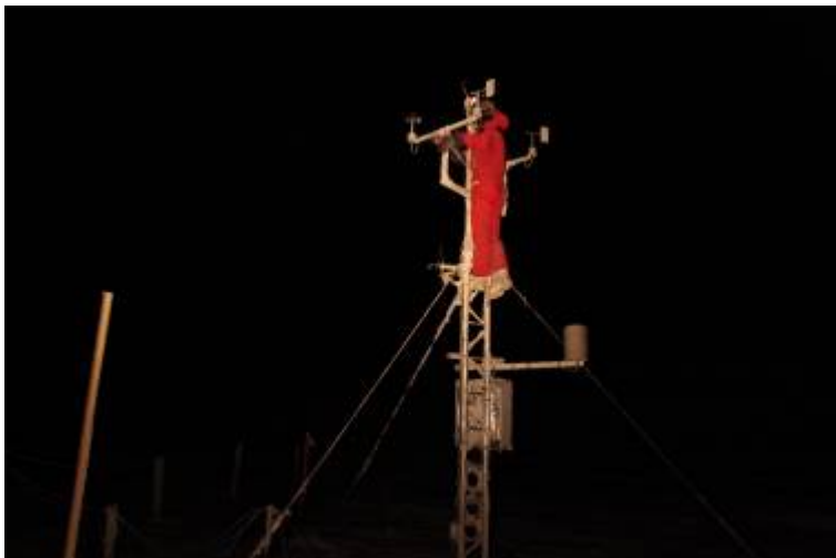
Intervento di pulizia della torre Milos 520 (con i misuratori meteo di temperatura, umidità, pressione, velocità e direzione del vento) durante la notte polare
